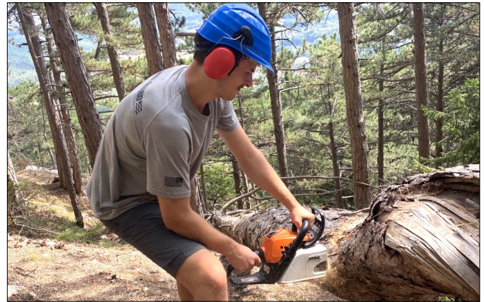
Sturzbaum-Entfernung am Wandfußsteig.
